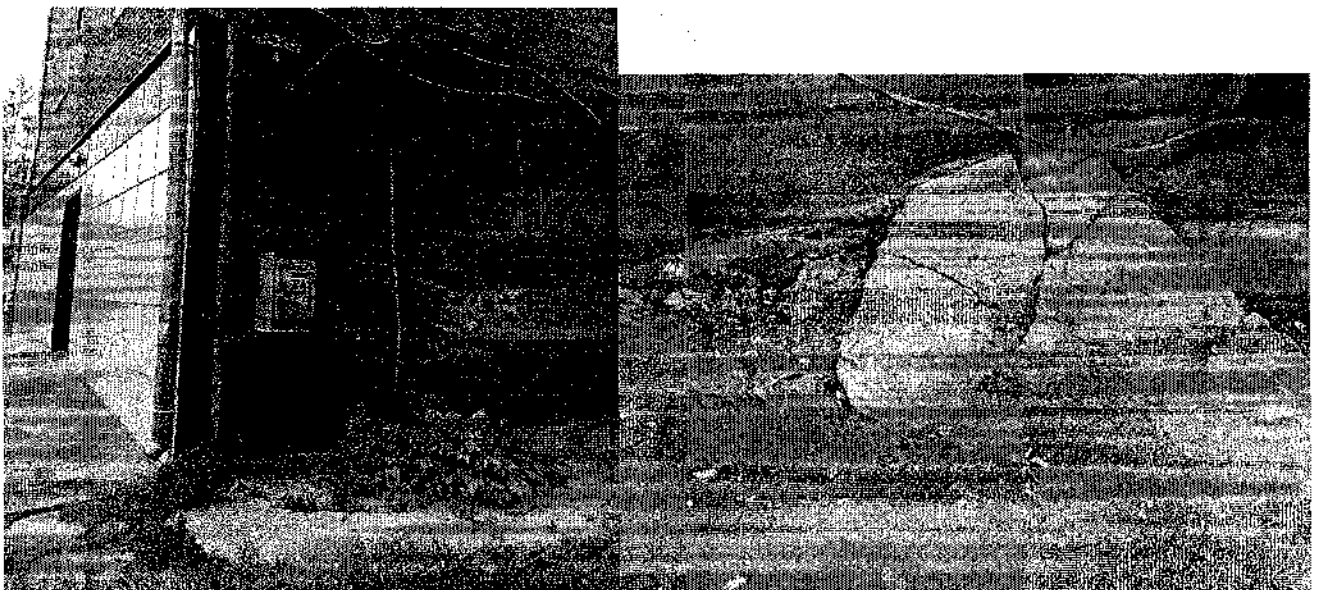
Фото 1. Разрушение отмостки. Разрушение защитного штукатурного покрытия с поверхностной эрозией кирпичной кладки цоколя здания. Следы биопоражения.
