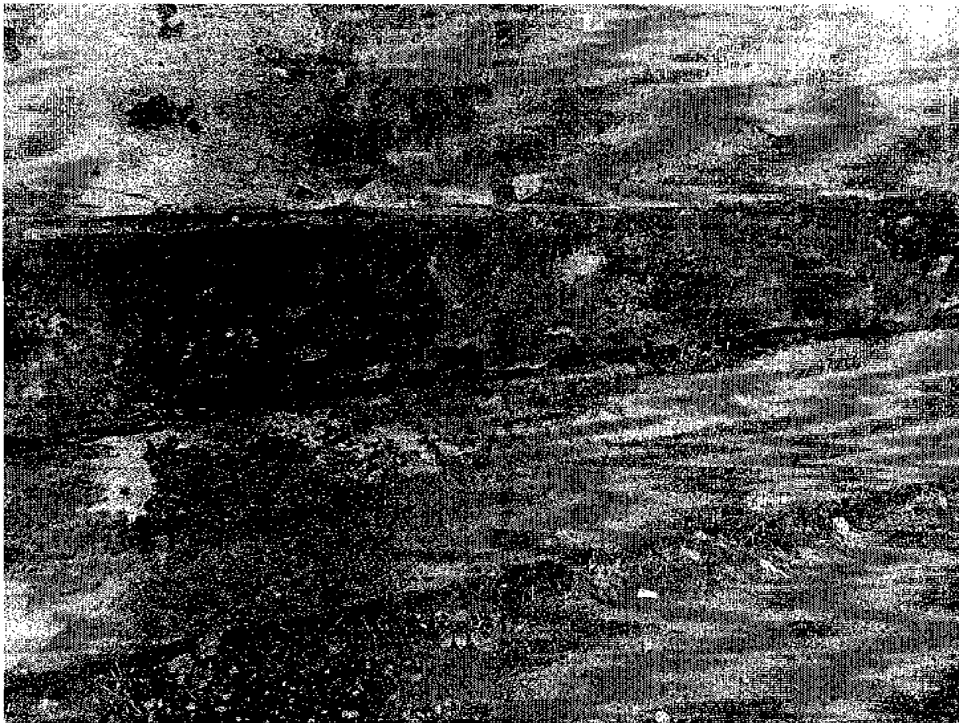
Фото 1. Разрушение отмостки. Разрушение защитного штукатурного покрытия с поверхностной эрозией кирпичной кладки цоколя здания. Следы биопоражения.
